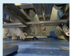
③マットの接着面を露出し、シャフトを下げた床に密着させる
