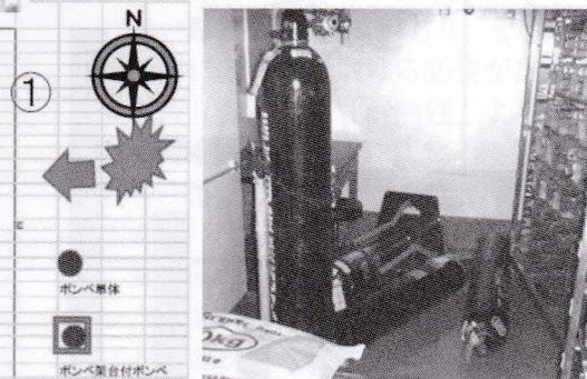
図1 東北大学における東日本大震災のボンベ被害例
